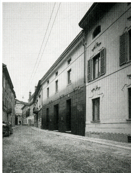
Fig. 12.3.a Scorcio della via Bonomelli, nel centro storico di Cremona.
