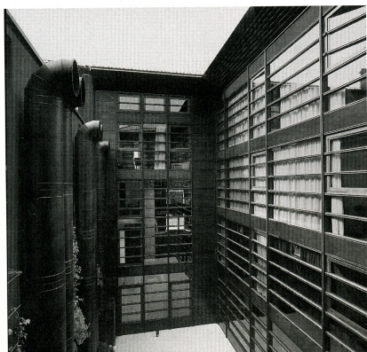
Fig. 12.3.d La corte dell'albergo, vero e proprio cuore dell'edificio, è caratterizzata da un aspetto tecnologico.
